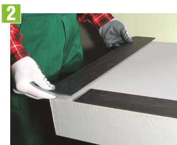
2 Uloženie montážnej šablóny pozdĺž okrajov balkónu
