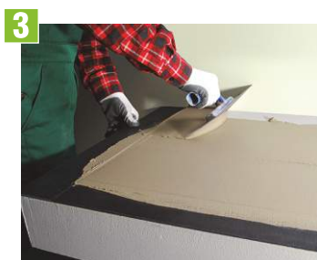
3 Nanášanie malty do kompenzačnej výšky šablóny
