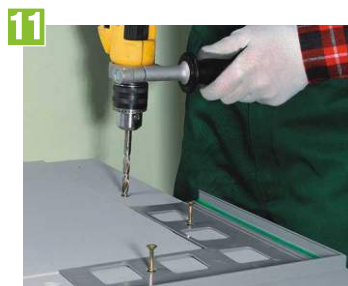
11 Vyvrtáme otvory, do ktorých vložíme hmoždinky
