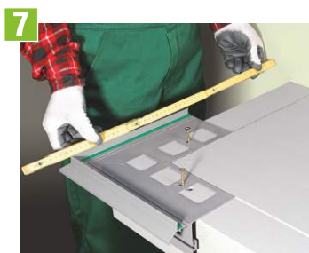
7 Začíname montážou rohových prvkov. Medzi profilmi necháme 2mm širokú dilatačnú škáru
