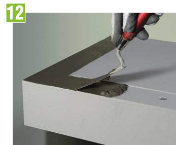
12 Nanesieme hydroizoláciu a inštalujeme profily
