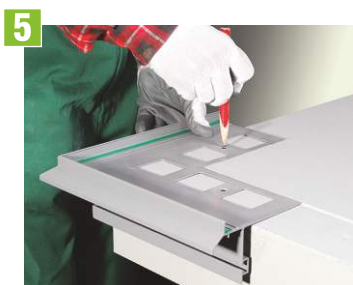
5 Označíme otvory pre montáž rohových prvkov
