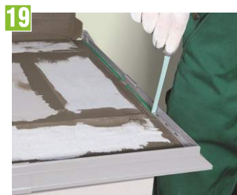
19 Odstránime ochrannú pásku, ktorá chráni otvory na odvádzanie vody po okrajoch profilu
