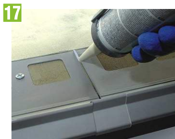
17 Dilatačné škáry vyplníme PU1K polyuretánovým tmelom
