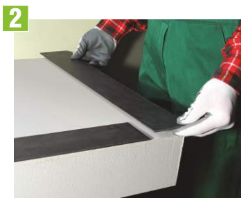
2 Uloženie montážnej šablóny pozdĺž okraja balkónu
