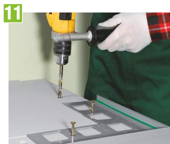
11 Vyvrtáme otvory a vložíme hmoždinky
