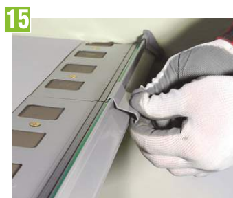
15 Montáž spojky L30/40
