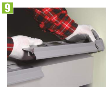
9 Pri stenách vynechajte medzery pre montáž krytiel OP30/40
