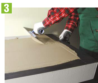
3 Nanášanie malty do kompenzačnej výšky šablóny
