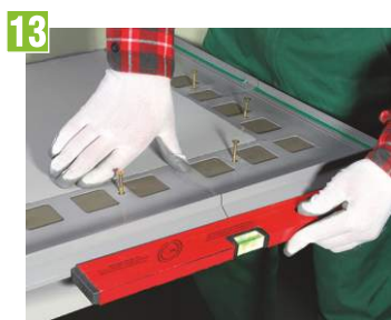
13 Osadenie profilov do roviny
