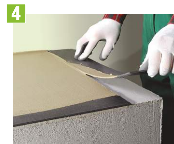
4 Po odstránení šablóny čakáme, pokiaľ malta vytvrdne
