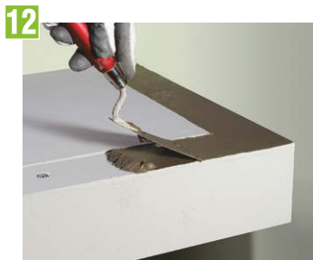
12 Nanesieme hydroizoláciu na báze cementu
