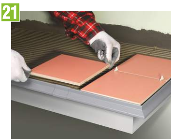
21 Položenie dlažby. Vynecháme medzeru 6mm od hrany profilu
