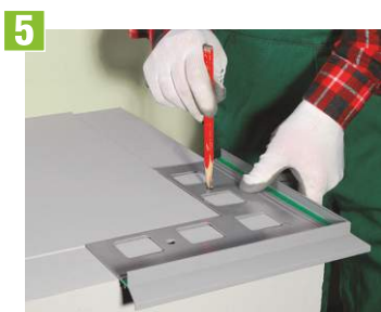
5 Označíme otvory na hmoždinky pre montáž rohového prvku
