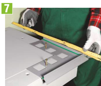
7 Ako prvé namontujeme rohy. Medzi profilmi vynechávame dilatačnú medzeru širokú 2mm
