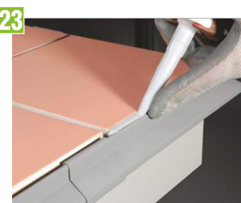
23 Zatmelenie škáry PU1K polyuretánovým tmelom
