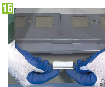
16 Montáž horizontálneho dilatačného prvku
