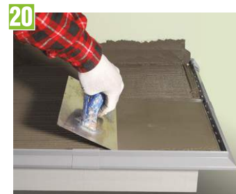
20 Aplikácia hydroizolácie
