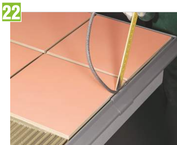
22 Vloženie dilatačnej šnúry medzi dlažbu a hranu profilu
