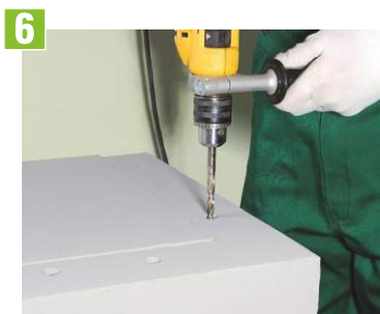
6 Vyvrtáme montážne otvory
