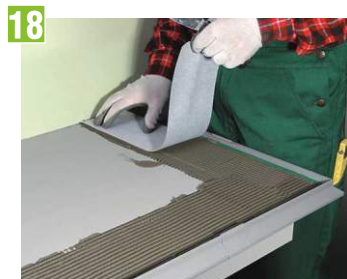
18 Pozdĺž vniútorného okraja profilu nanesieme hydroizolačnú maltu, do ktorej uchyťme tesniaci pás široký min. 10cm
